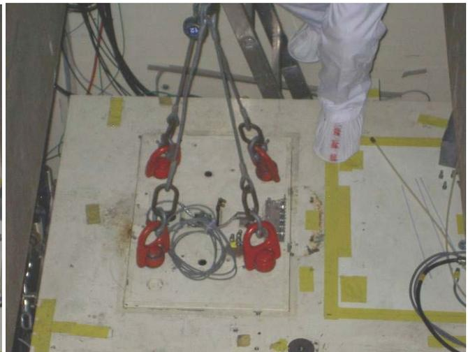
Targetstation am Kranhaken anhängen, anheben und im bereitstehenden Montagegestell deponieren.
