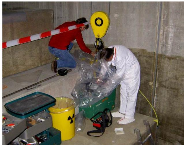
Antrieb auf dem Bestrahlungsbunkerdach eingepackt deponieren.
