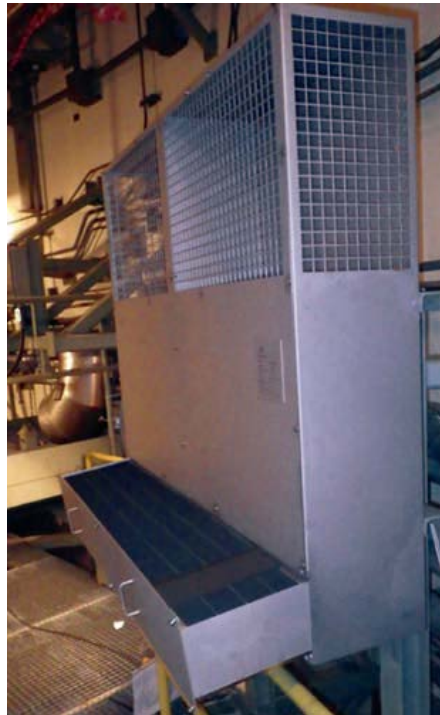
PAR installation in Cofrentes NPP
